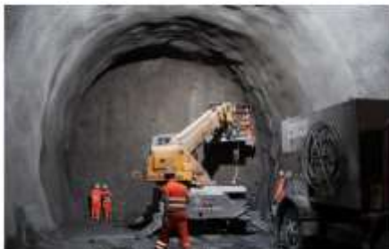
隧道内施工人员、工具车
